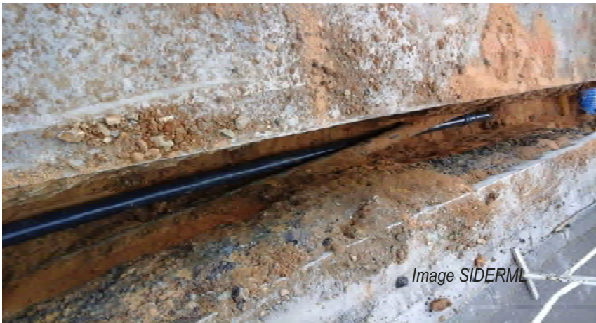
Pose d'une canalisation en PVC conforme
