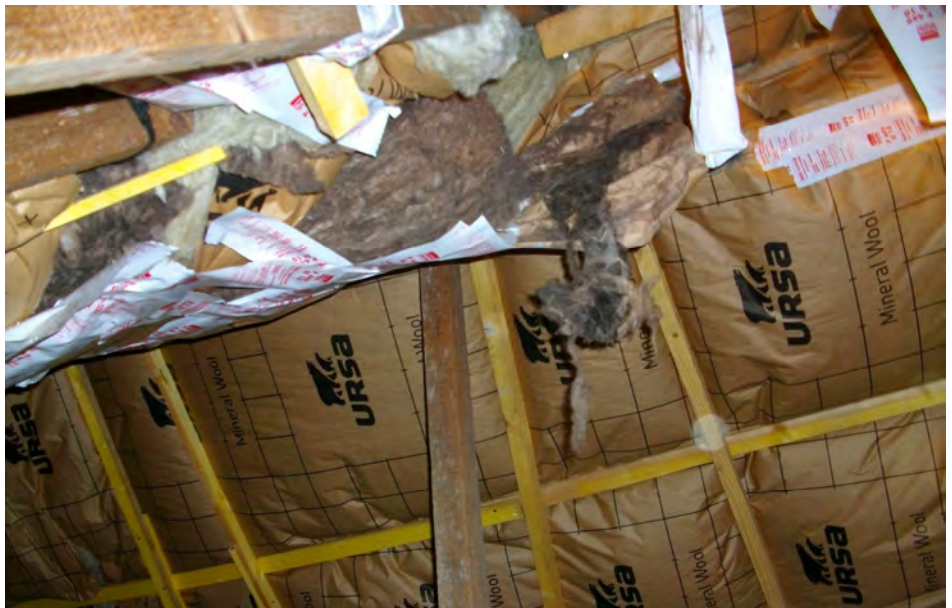
Isolation à 1 € : réalisation catastrophique chez un de nos adhérents
